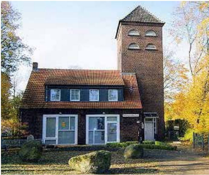
Das ehemalige Gerätehaus der Feuerwehr Hiltrup von 1934, Umbau zum Hiltruper Museum 1998
