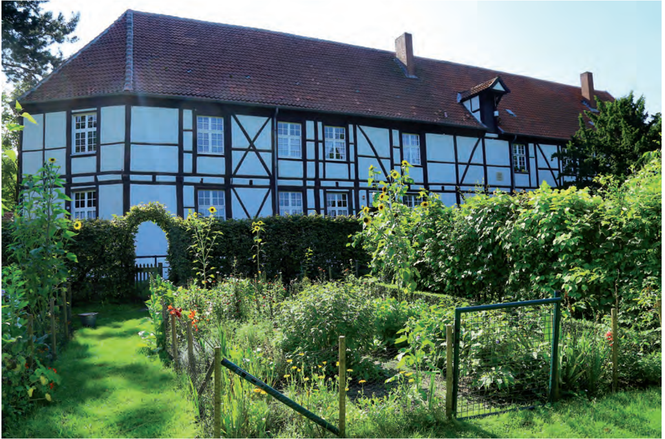
Ehemaliges Werk- und Armenhaus (Pfründnerhaus)
