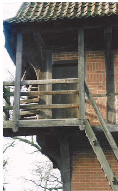
Die rekonstruierte Außentreppe: Oberes Podest mit den Hängegeständern
