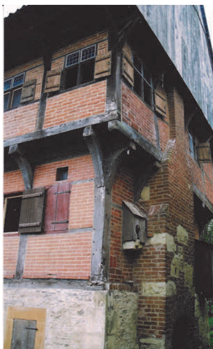
Die Nord-/Ostecke mit dem alten, gotischen Fenster rechts oben, dem Wasserausguss und Kaminzug
