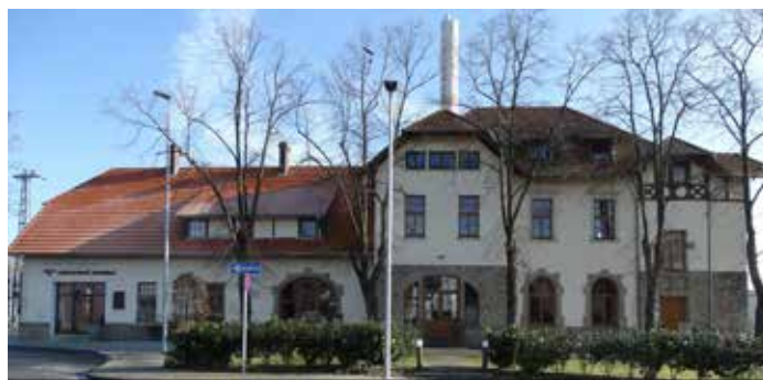
Eingangsbereich des Kulturbahnhofes mit dem Restaurant PAMINA - linke Seite - Aufnahme Frank Schäfer
