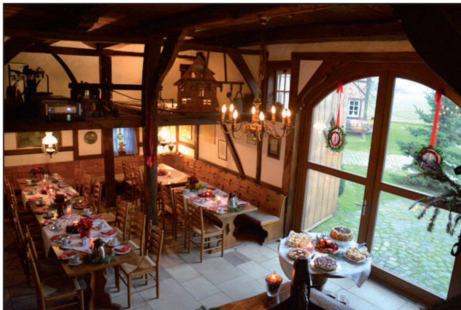
Verglaste Flügeltüren im Tennentorbogen
