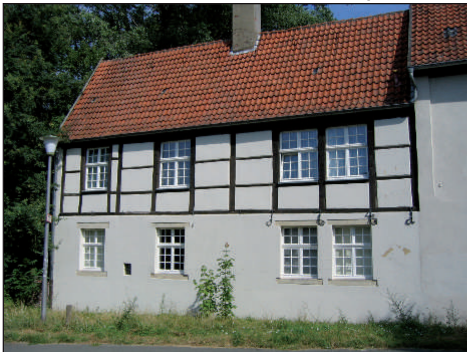
Gebäude des Lepramuseums, Kinderhaus 15, Rückseite (Südseite).
