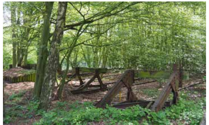
Endpunkt der Gleisanlage - Reste der Prellböcke
