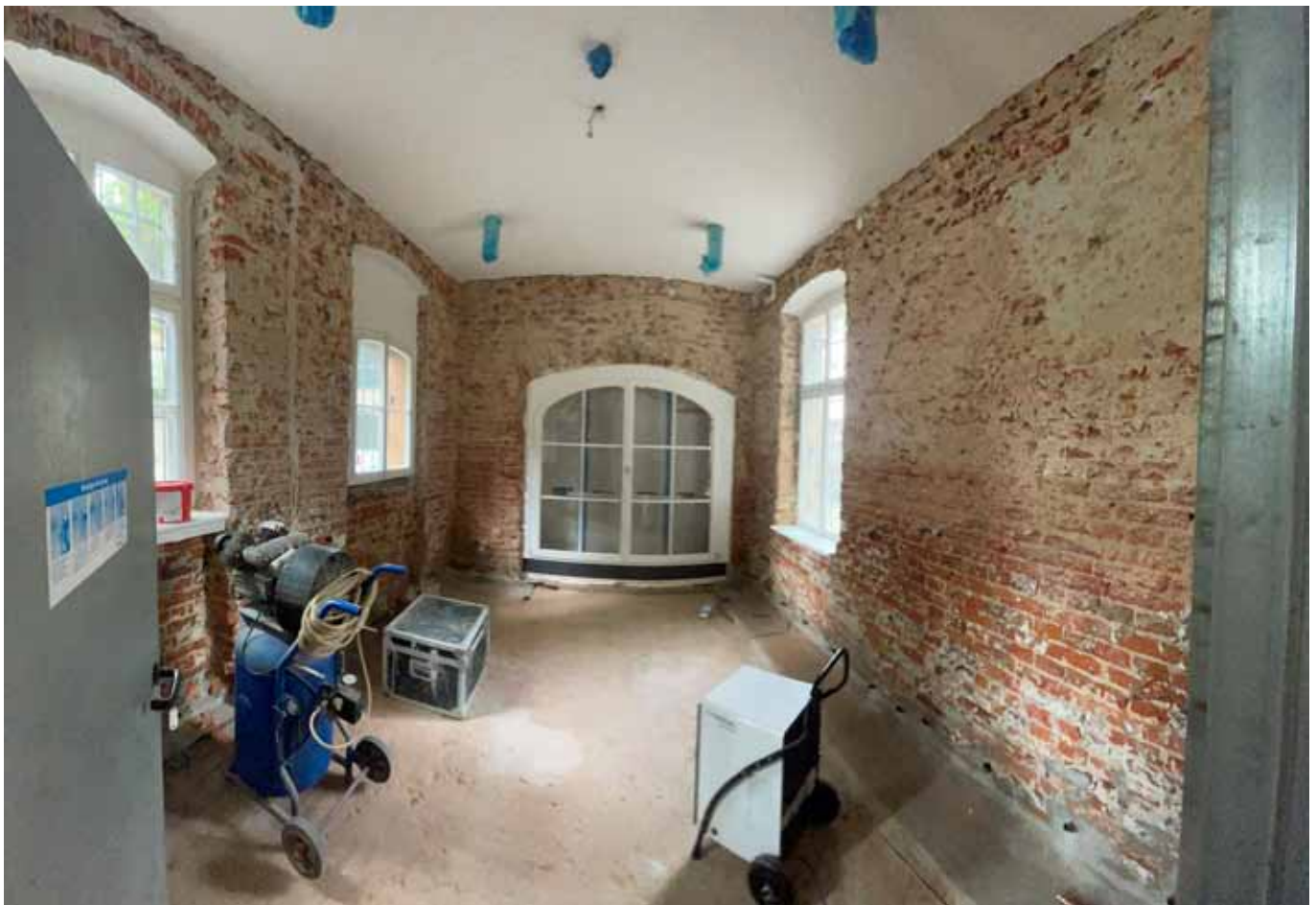
Im hinteren Raum wurde der von Schimmel befallene Putz komplett abgeschlagen und neu verputzt.
