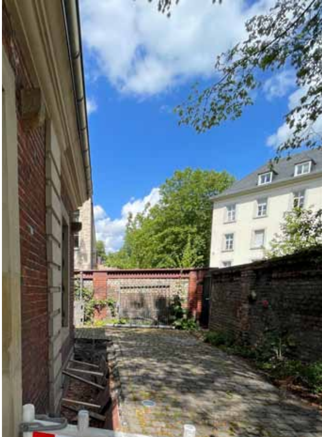
Der Bereich des ehemaligen Pferdestalles wurde ausgekoffert und Bleche gegen aufsteigendes Wasser ins Mauerwerk getrieben
