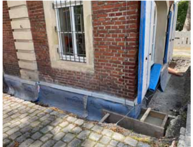
Rund um den Pferdestall wurde das Kopfsteinpflaster entfernt und der Sockel des Torhauses speziell mit Dämmmaterial abisoliert.
